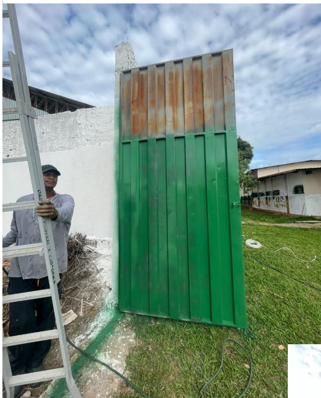
Pintura de Portões nas Laterais do Muro
